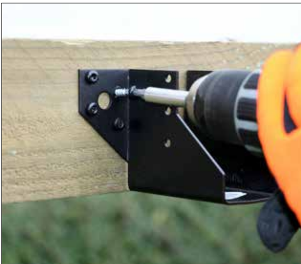
Estribo SAE-PB negro instalado con tornillos CSA-PB
