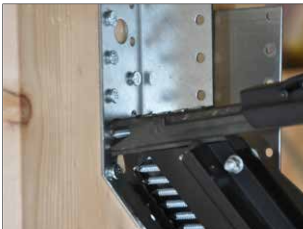
Estribo SAE instalado con CNAPC34
