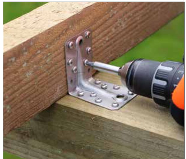
ABR7015S de acero inoxidable A4 instalado con tornillos para conector CSA-S de acero inoxidable A4
