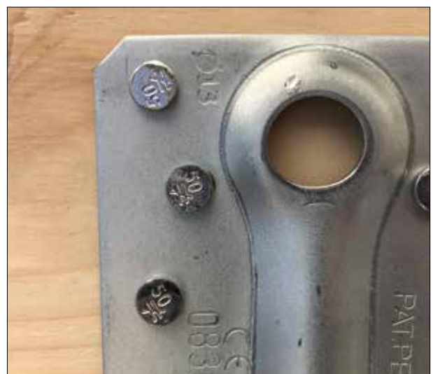
Las marcas del conector, sumadas a las marcas en las cabezas de los puntas, facilitan la verificación tras la colocación
