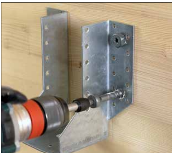
Estribo SAE instalado con SSH
