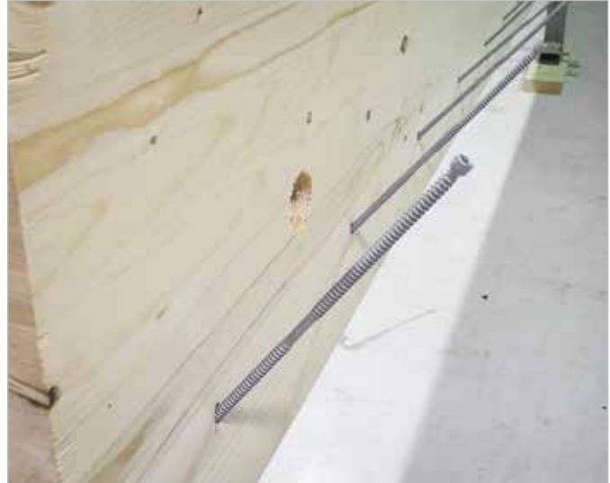
Tornillos SWD utilizados para una unión de muro de CLT sobre tablero de CLT
