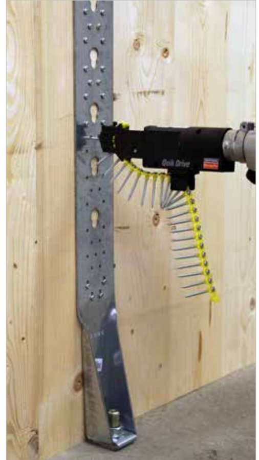
Anclaje HTT31 fijado con tornillos en cinta CSA en una conexión de muro de CLT sobre losa de hormigón
