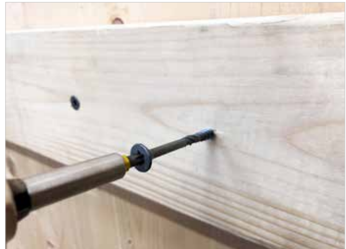
Riostra fijada con tornillos TTZNFS
